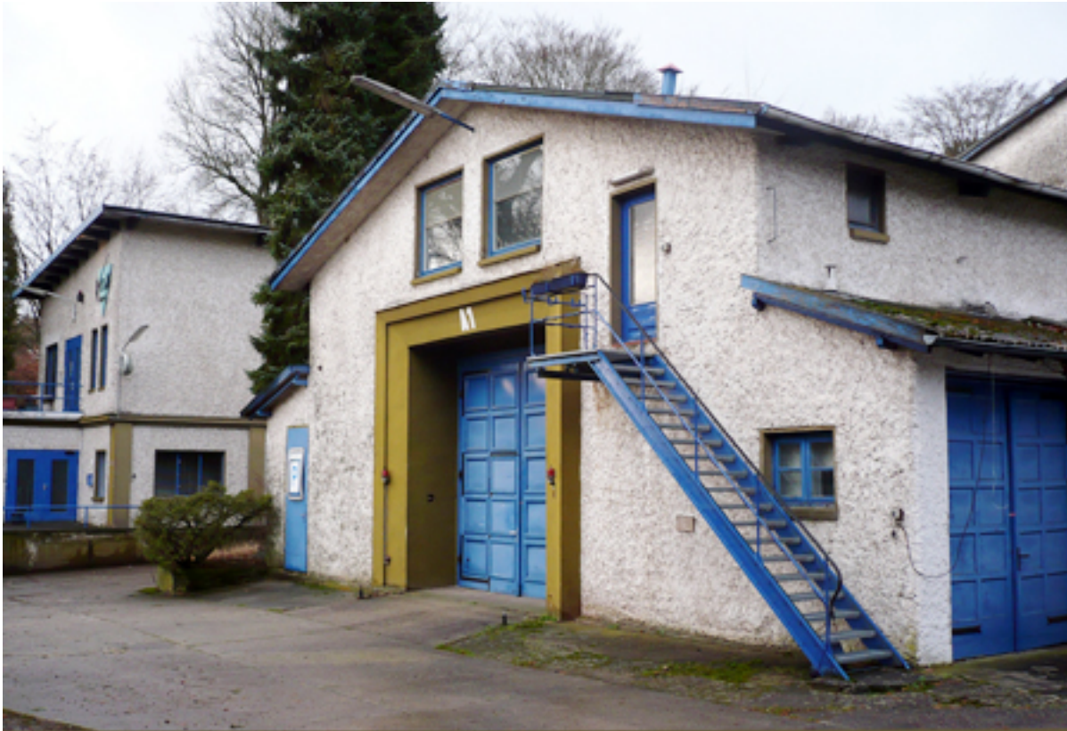
Zufahrt aufs Gelände, rechts Halle A1. Foto: Barbara Derboven
